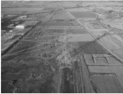
蔚门 I、II 回 1#塔处附近牵张场及施工便道恢复情况
