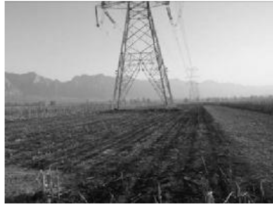
蔚门 I、II 回 14#塔附近牵张场及施工便道恢复情况
