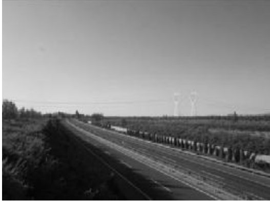
蔚门 I、II 回 55-56#塔 线路交叉跨越 S10 张石高速
