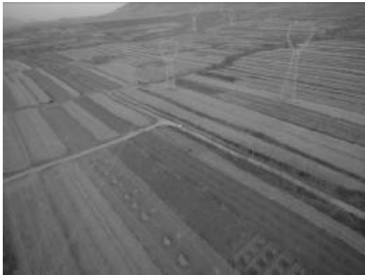
蔚门 I、II 回 135#塔附近牵张场及施工便道恢复情况
