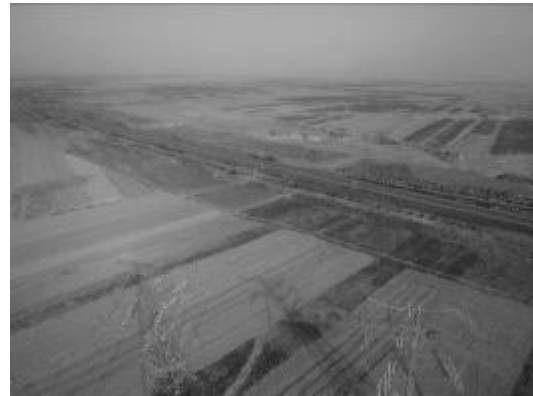
蔚门 I、II 回 55#塔附近牵张场及施工便道恢复情况
