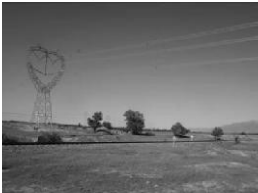
蔚门 I、II 回 37-38#塔
