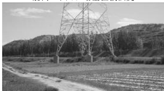
蔚门 II 回 70#塔基植被恢复
