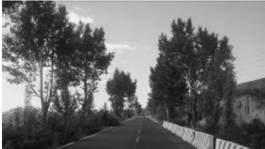
蔚门 I、II 回 198-199#塔 线路交叉跨越 S241 省道
