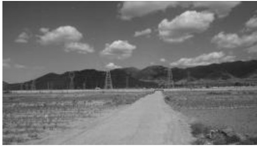
利用施工便道状况
