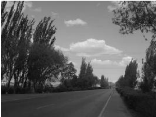
蔚门 I、II 回 121-122#塔 线路交叉跨越 G109 国道
