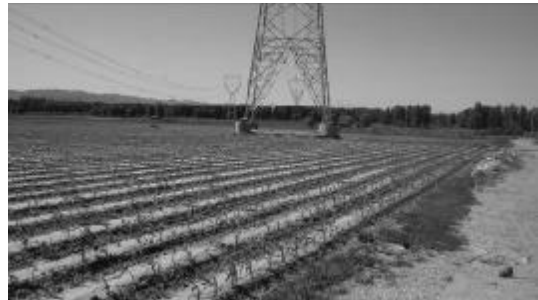
蔚门 II 回 34#塔基周边农业耕作恢复情况
