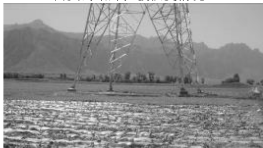
蔚门 I、II 回 5#塔基植被恢复
