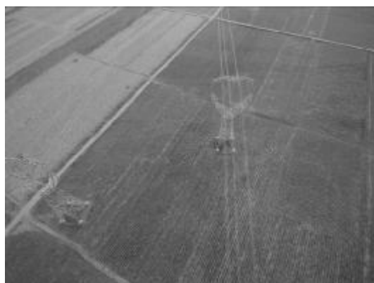
蔚门 I、II 回 34#塔基恢复情况
