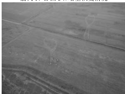
蔚门 I、II 回 68#塔基恢复情况
