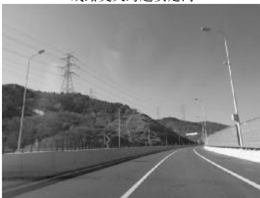
蔚门 I、II 回线路交叉跨越 G108 国道
