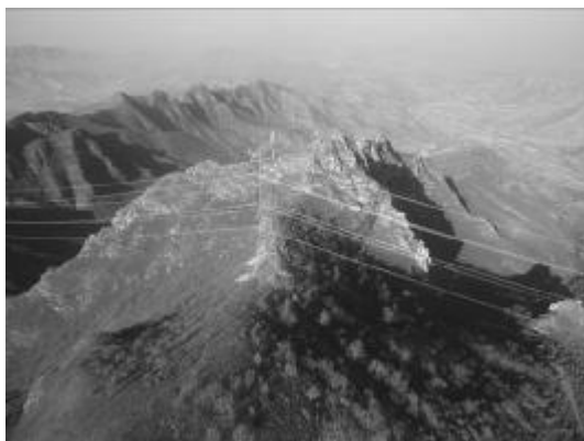
蔚门 I、II 回 209#塔基恢复情况
