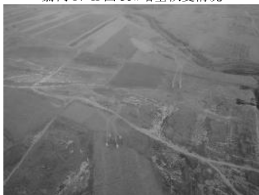
蔚门 I、II 回 69#塔基恢复情况
