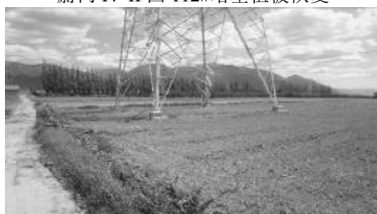
蔚门 II 回 120#塔基植被恢复
