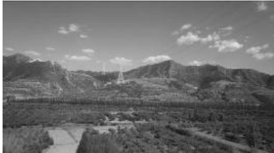
蔚门 I、II 回 178-179#塔 线路交叉跨越 G109 国道
