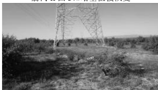
蔚门 II 回 50#塔基植被恢复
