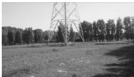
蔚门 II 回 37#塔基植被恢复
