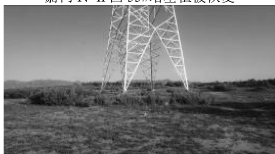
蔚门 I 回 60#塔基植被恢复
