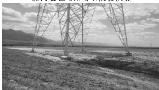
蔚门 II 回 105#塔基植被恢复
