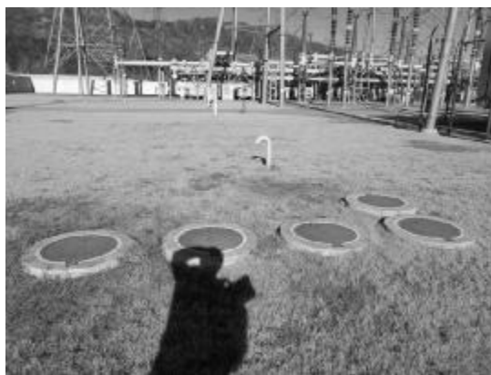
主变事故油池
