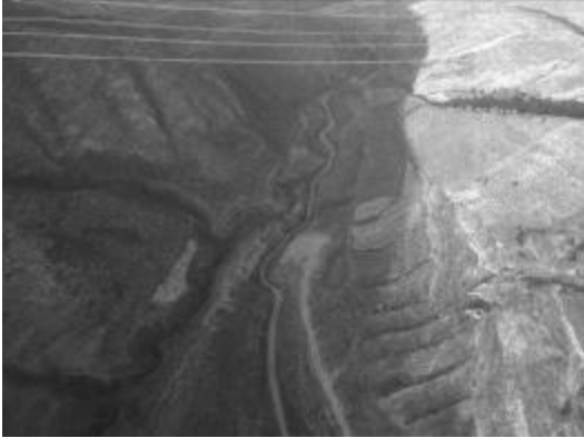
蔚门 I、II 回 189#~190#塔附近牵张场及施工便道恢复情况
