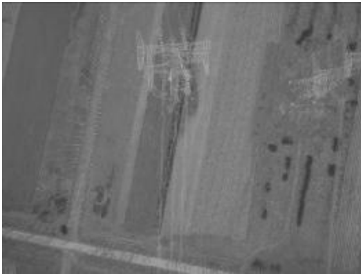
蔚门 I、II 回 74#塔附近牵张场及施工便道恢复情况
