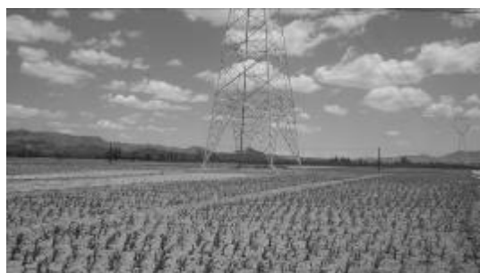
蔚门 I 回 105#塔基植被恢复
