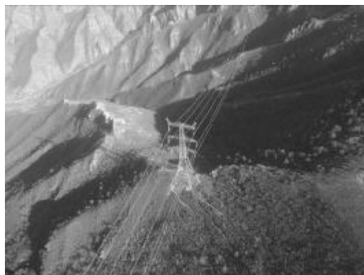
蔚门 I、II 回 210#塔基恢复情况
