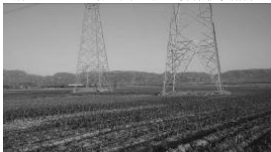
蔚门 I、II 回 67#塔基周边农业耕作恢复情况
