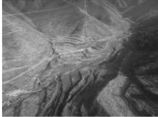
蔚门 I、II 回 206#~207#塔附近牵张场及施工便道恢复情况
