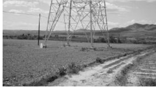
利用施工便道状况
