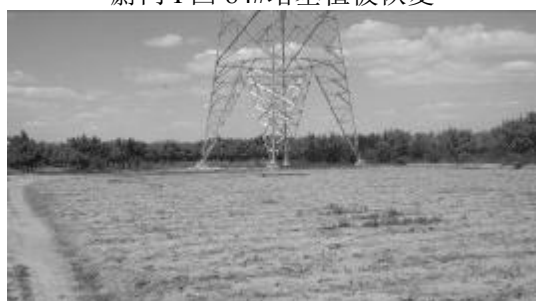
蔚门 I 回 87#塔基植被恢复
