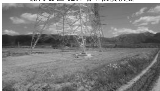
蔚门 I 回 132#塔基植被恢复
