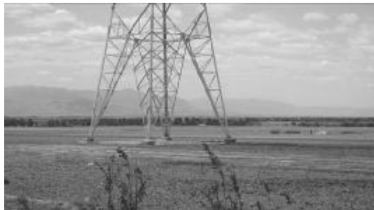
蔚门 II 回 95#塔基周边农业耕作恢复情况
