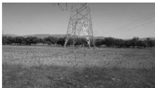
蔚门 I 回 37#塔基植被恢复
