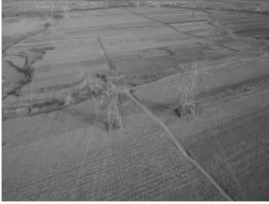
蔚门 I、II 回 111#塔附近牵张场及施工便道恢复情况
