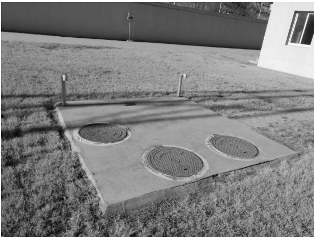
图 9.1-1 门头沟变电站内一体化污水处理装置
