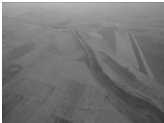
蔚门 I、II 回 69-70#塔 线路交叉跨越壶流河
