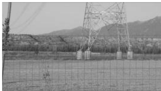
蔚门 II 回 68#塔基植被恢复
