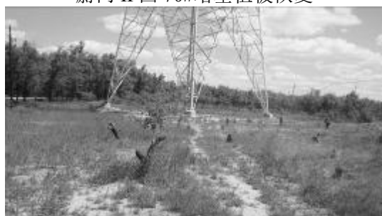
蔚门 I 回 84#塔基植被恢复
