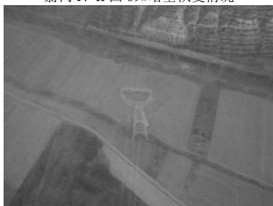
蔚门 II 回 70#塔基恢复情况
