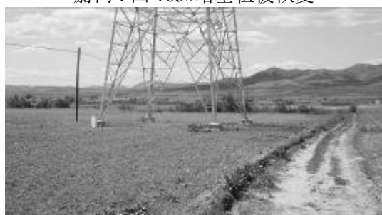
蔚门 I 回 120#塔基植被恢复
