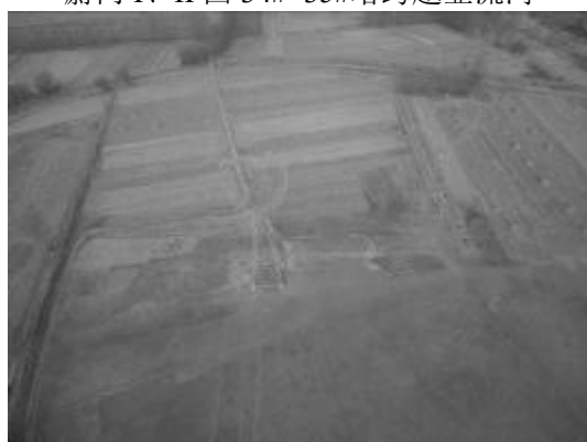
蔚门 I、II 回 35#塔基恢复情况
