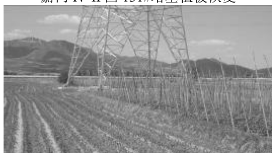
蔚门 II 回 132#塔基植被恢复
