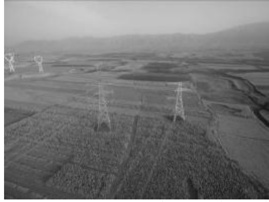
蔚门 I、II 回 124#塔附近牵张场及施工便道恢复情况
