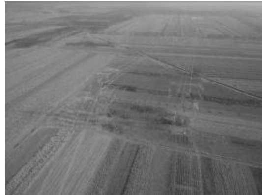
蔚门 I、II 回 90#塔附近牵张场及施工便道恢复情况
