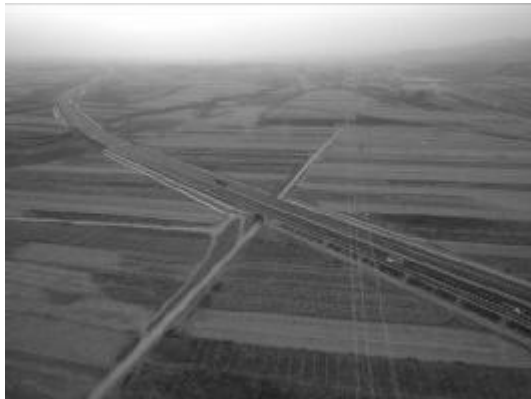
蔚门 I、II 回 131-132#塔 线路交叉跨越在建高速（广浑高速）
