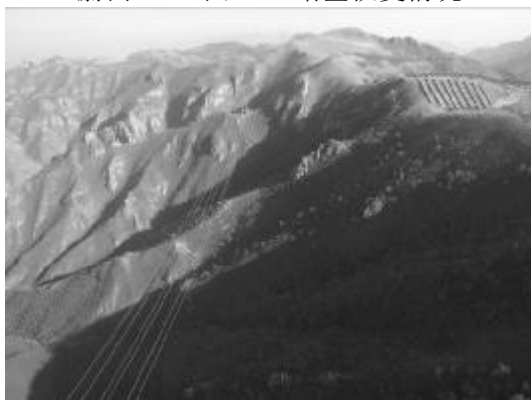
蔚门 I、II 回 211#塔基恢复情况
