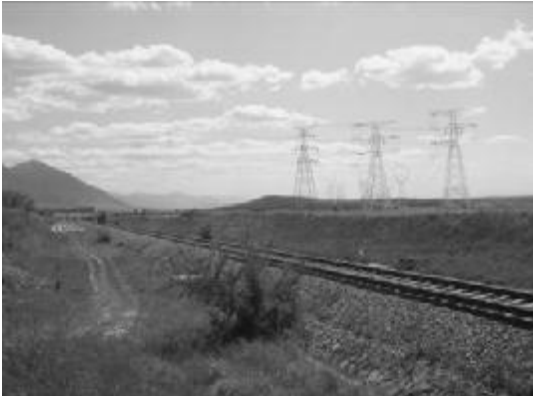
蔚门 I、II 回 130-131#塔 线路交叉跨越沙蔚铁路
