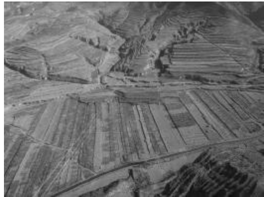
蔚门 I、II 回 173#塔附近牵张场及施工便道恢复情况
