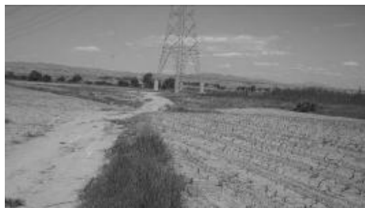
蔚门 I 回 70#塔基植被恢复
