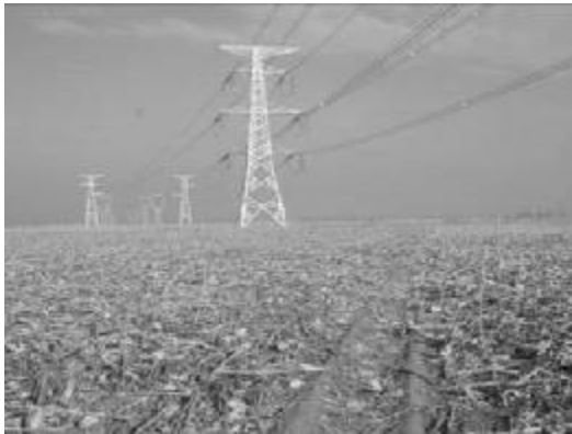
蔚门 I、II 回 28#塔附近牵张场及施工便道恢复情况
