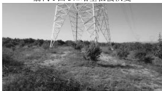
蔚门 I 回 50#塔基植被恢复
