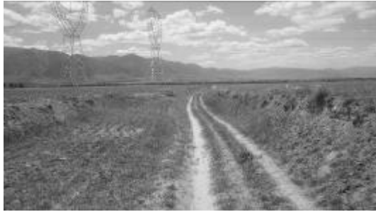
利用施工便道状况
