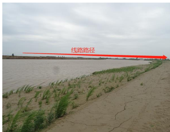
本工程跨越陕西渭河湿地处
