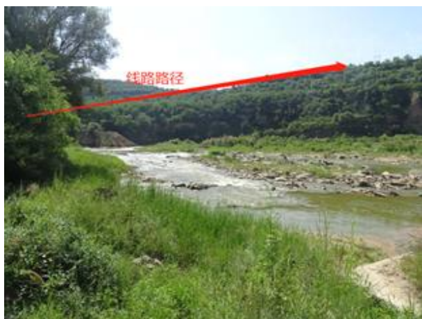
本工程跨越陕西北洛河湿地处
